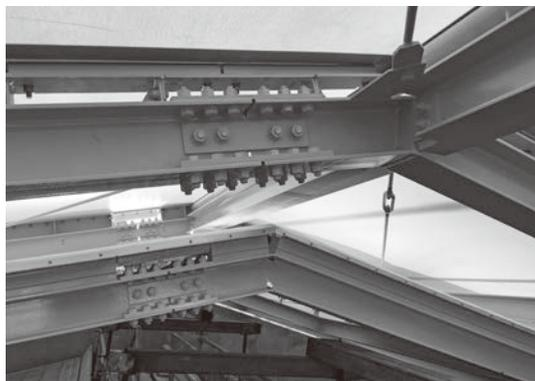
⑥膜定着部 (鉄骨骨組ボルト接合部)
