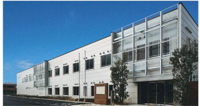
住金システム建築の施行事例
