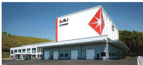
JFEシビルのメタルビル建築
